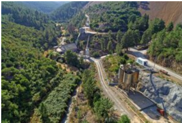
ETAM (Estação de Tratamento de Água das Minas)
